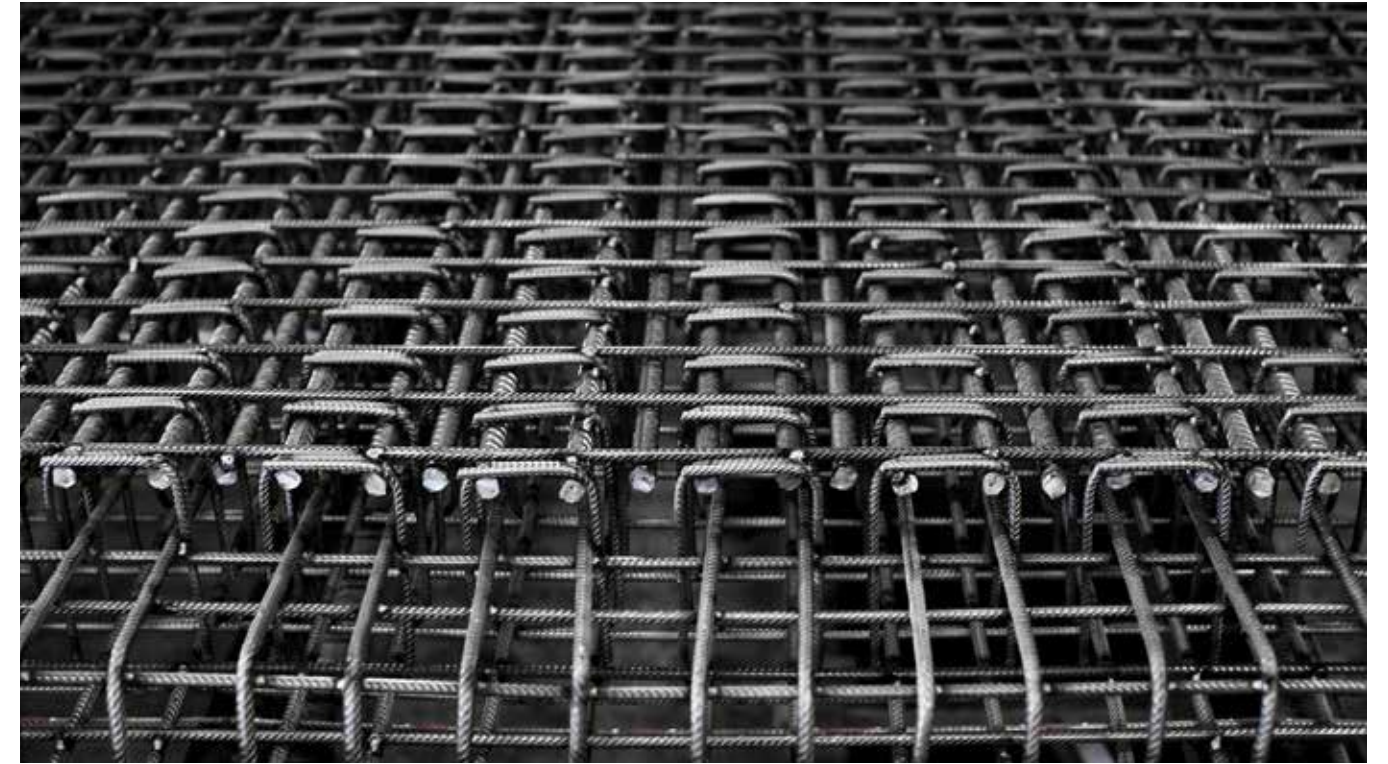
Schwere Bewehrung für den Ingenieurtiefbau.
